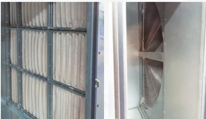
Mit den sich drehenden Wärmerädern kann aus der Kabinenabluft sowohl Wärme als auch Luftfeuchtigkeit zurückgewonnen werden.
