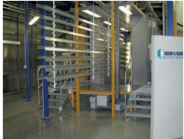
Die Pulverkabine wurde mit acht elektrostatischen Automatikpistolen sowie einer automatischen Teileerkennung ausgestattet, die es ermöglicht, den Materialverbrauch zu reduzieren.
