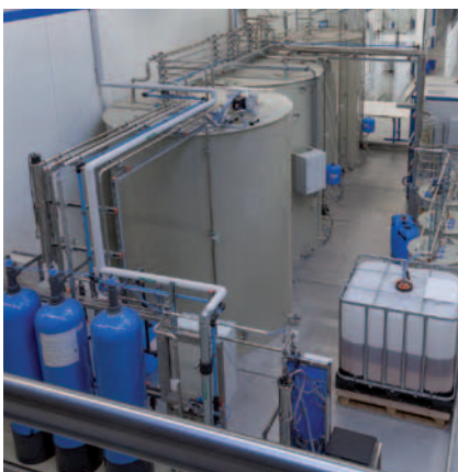
Die Betriebsmedien werden bei Groke zentral bereitgehalten und vor der Entsorgung umweltgerecht aufbereitet.
